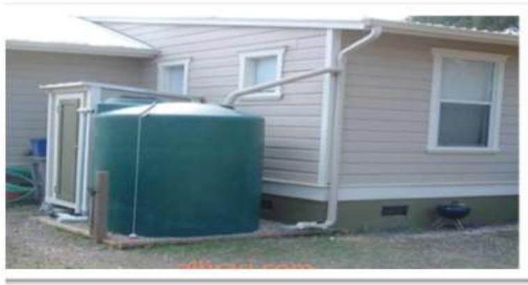
[شكل (3) : صورة لنظام الأسطح المائية]
